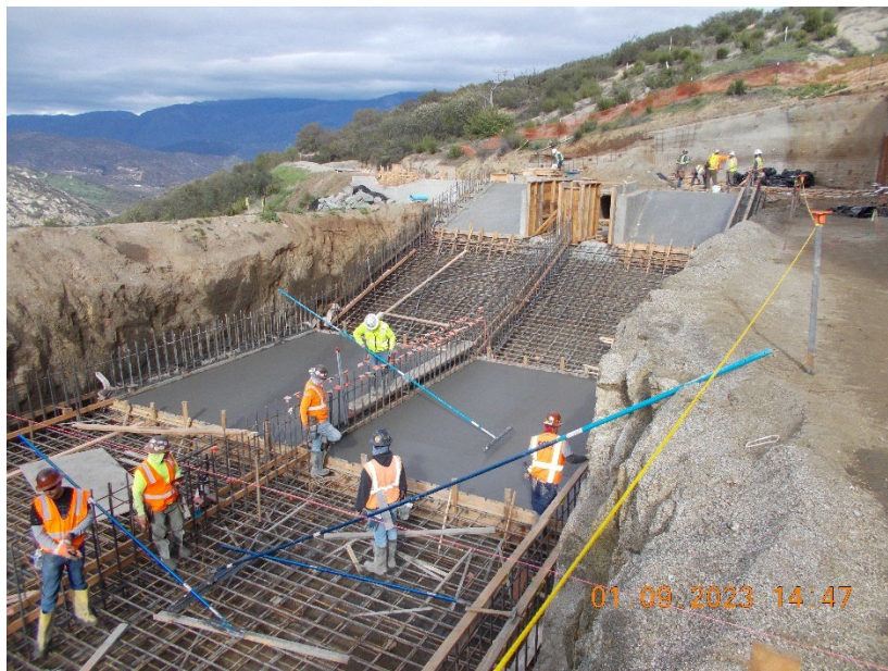
Concrete pour for desilting basin slab
