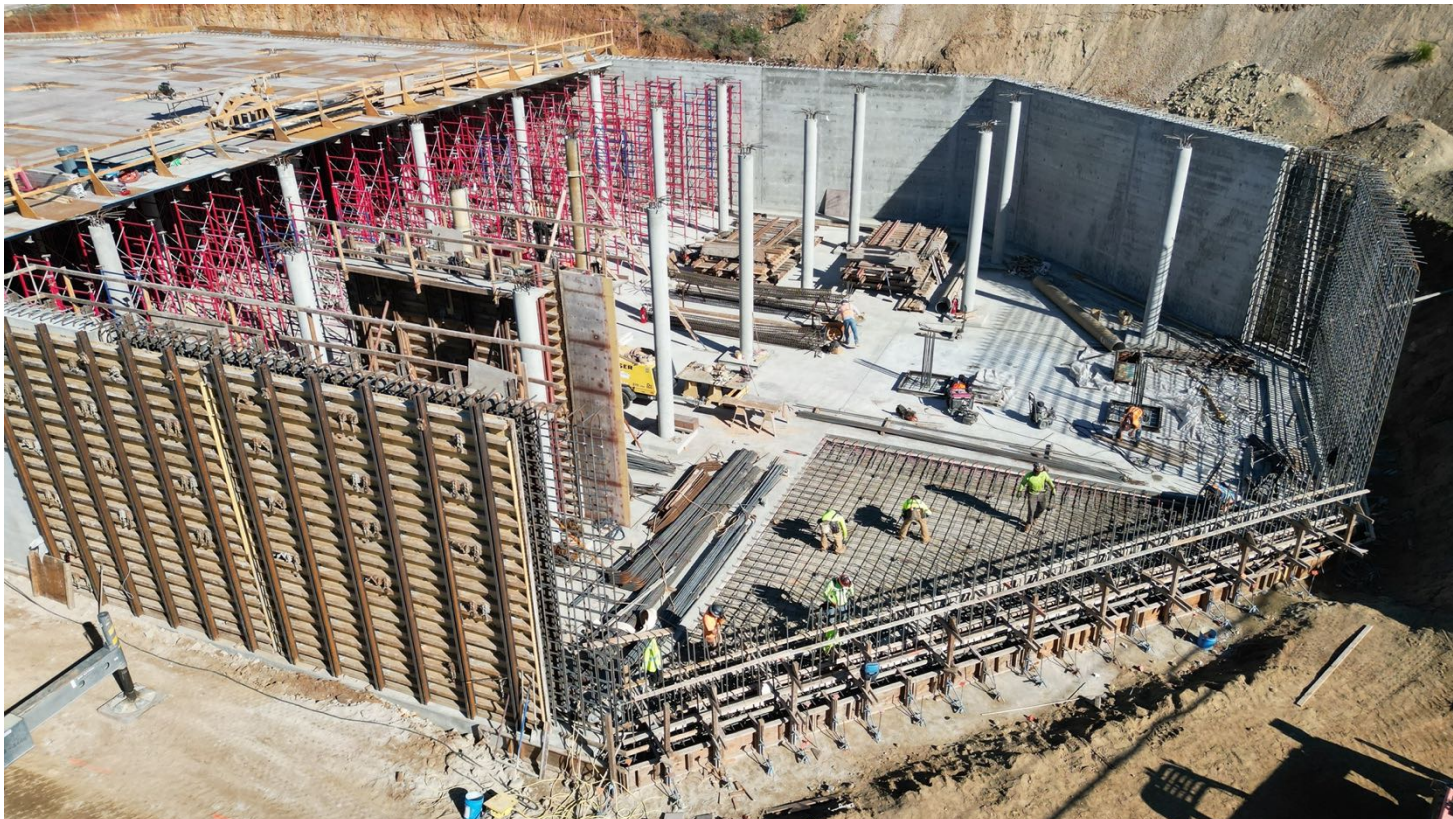
Rebar placement for final SOG pour (above). Final SOG concrete slab placement (below)
