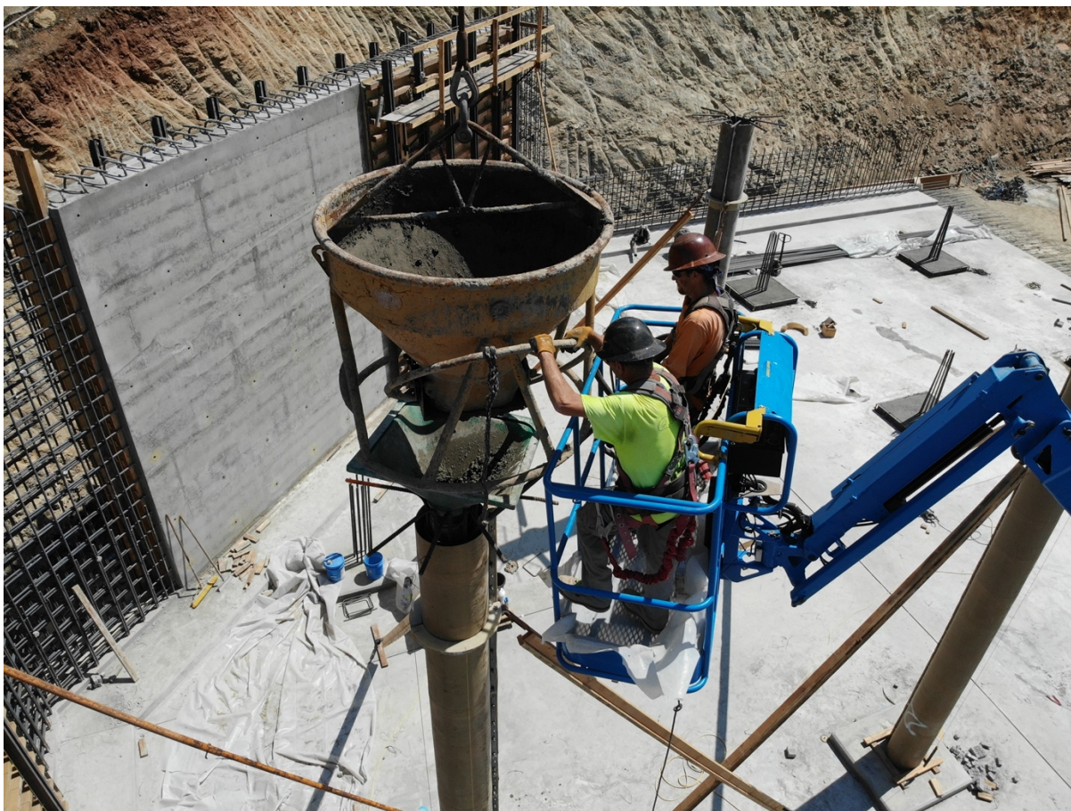
Pouring Columns (Below)
