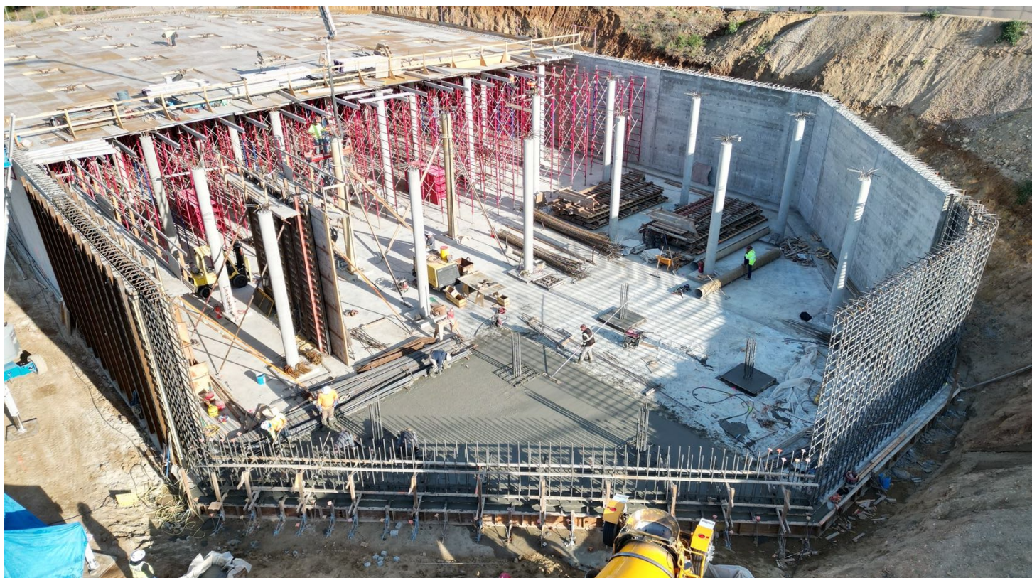
Rebar placement for final SOG pour (above). Final SOG concrete slab placement (below)
